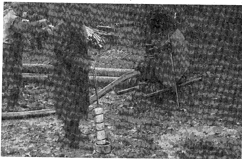
153. ábra. 5 kg-os trotil-töltet beengedése a zánkai úttörőtábor kísérleti kútjába (1966. november)
