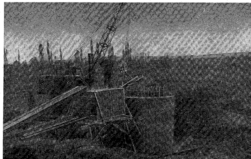
53. ábra. Aknakút süllyesztése gépi markolóval Keszthelyen (1962. április)
