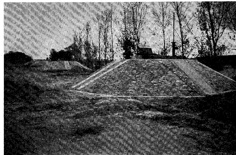
139. ábra. A bajai partiszűrősű vízmű kútjainak feltöltött kiképzése (1969. október)
