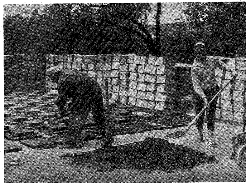
31. ábra. Betonelemek előregyártása Alsóörsön. A kút vázát alkotó beton idomkövek a telep szélén deponálva (1963. augusztus)
