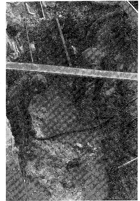
23. ábra. Pápa–Tapolcafi aknaktíjából mészkőkifejtés kompresso-ros légkalapáccsal (1966. október)
