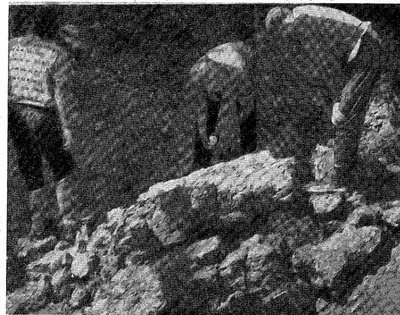
26. ábra. Robbantással szétrepesztett mészkő a Pápa – Tapolcafőn épült kútban (1967. augusztus)
