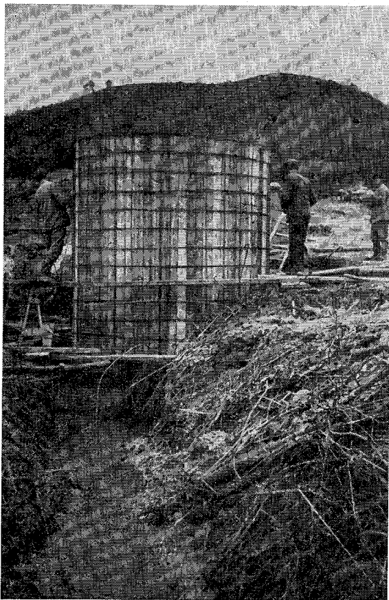
54. ábra. Aknakút második süllyesztésre kerülő lépcső betonzsaluzatának és vasszerelésének készítése (1962. április)
