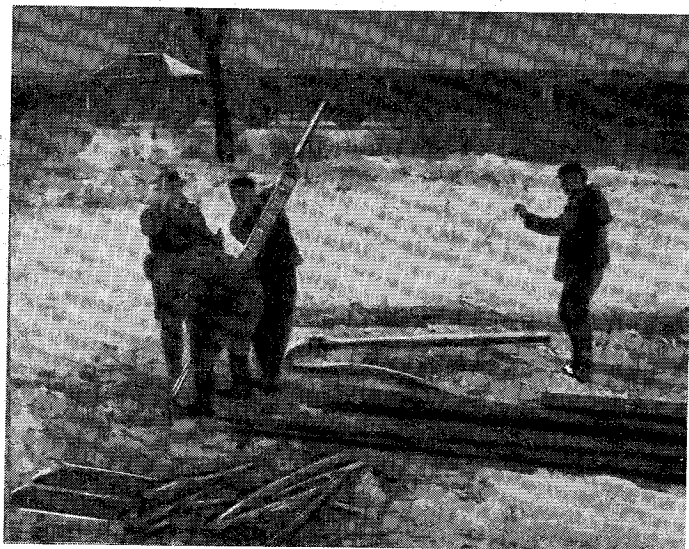
154. ábra. Faléchez erősített trotil-töltet beengedése a balatonrendesi kútba (1967. január)
