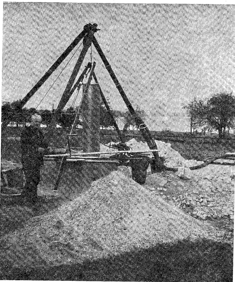
20. ábra. Balatonakali keleti campingkútja készítés közben (1965. április)
